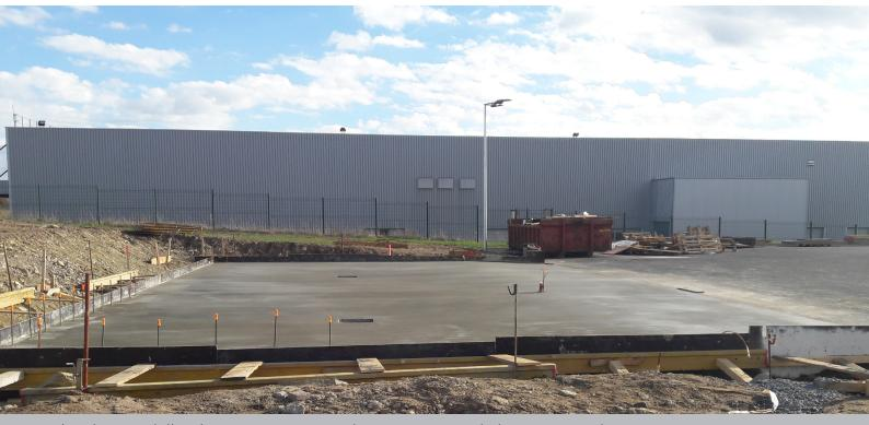
Le plancher en dalle pleine est constitué d'une épaisseur de béton armé de 15 à 20 cm en moyenne, coulée sur un coffrage plat et comporte des armatures d'acier variant en nombre et en diamètre selon la portée et les charges à supporter.
